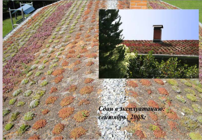
Скатная кровля. Частный дом, Московская область
