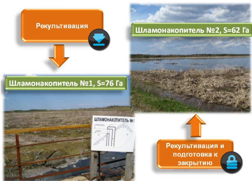
Рис. 1. Внешний вид шламонакопителей ОАО «Монди СЛПК»
