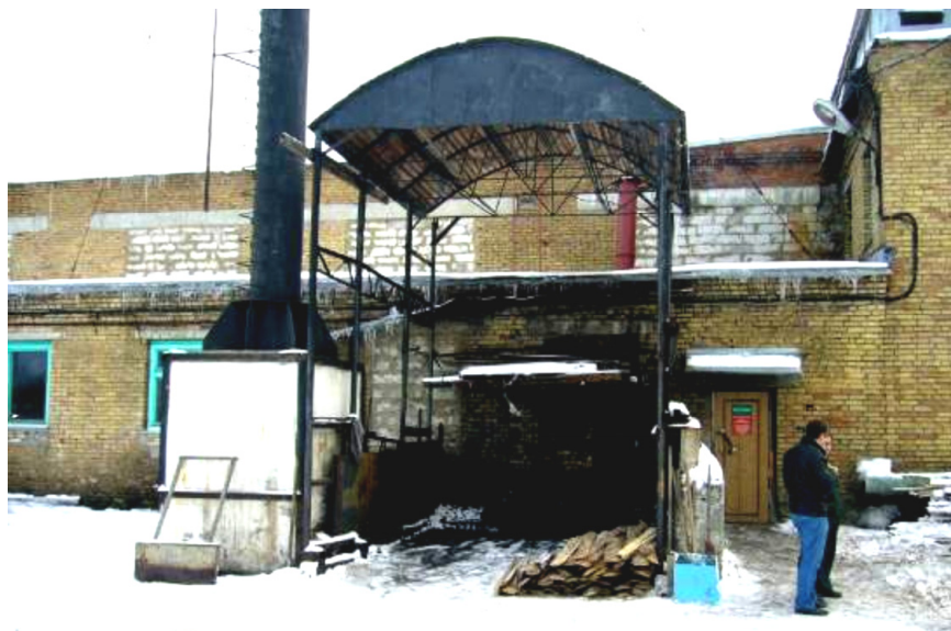
Рис. 41. Котельная Сыктывкарского лесного института
